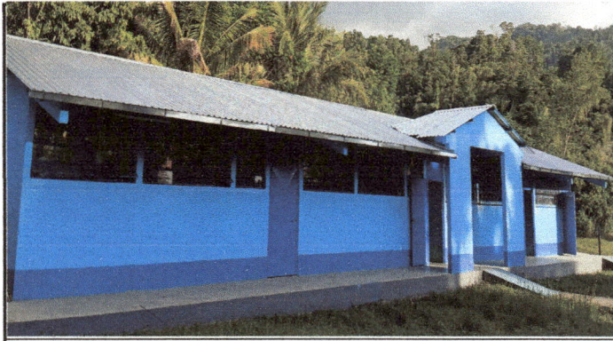
Foto1: Modulo 1: Evidencia del centro educativo despues de la sustitucion de las laminas a troqueladas.
