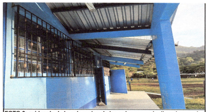
FOTO 6: evidencia de la colocacion de los valcones en la direccion y aula de Tercero Basico.
