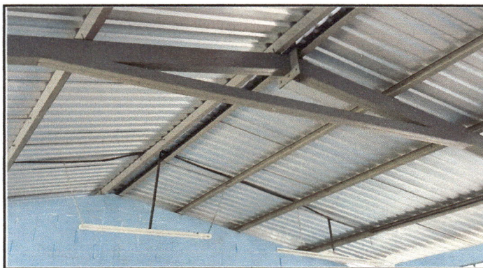
Foto 3: Modulo 3: fotografia de la Estructura de Techo despues de los trabajos realizados.
