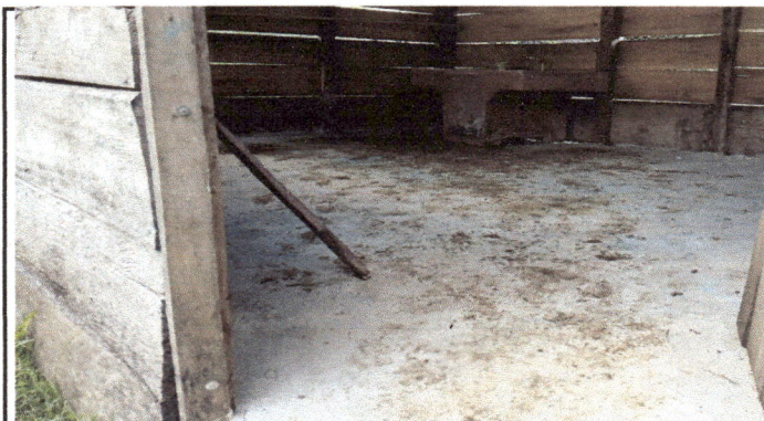
.Tambien se mejoro un poco la cosina del centro educativo con el material sobrado se le aplico piso de torta de cemento.
