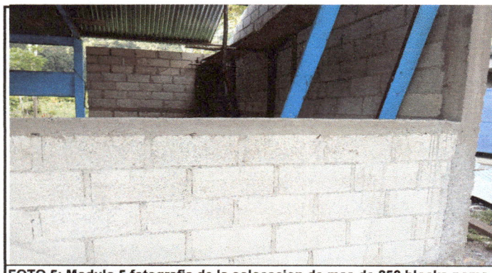
FOTO 5: Modulo 5 fotografia de la colocacion de mas de 250 blocks poma en el salon.
