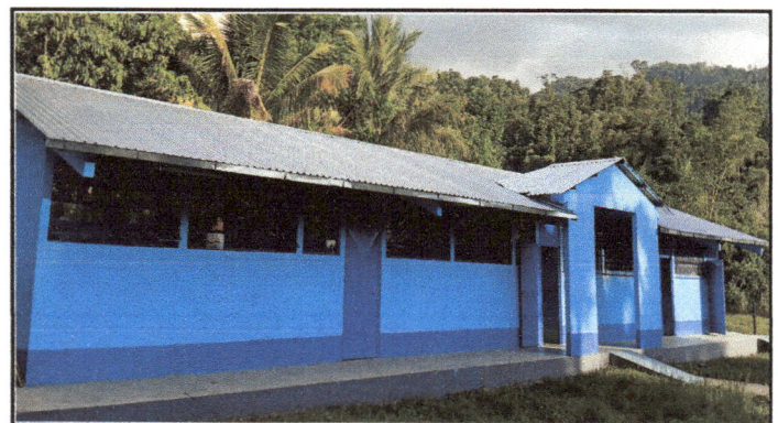
Foto 4: MODULO 4: evidencia de las puerta que se hizo mantenimiento y sustitucion de las chapas.
