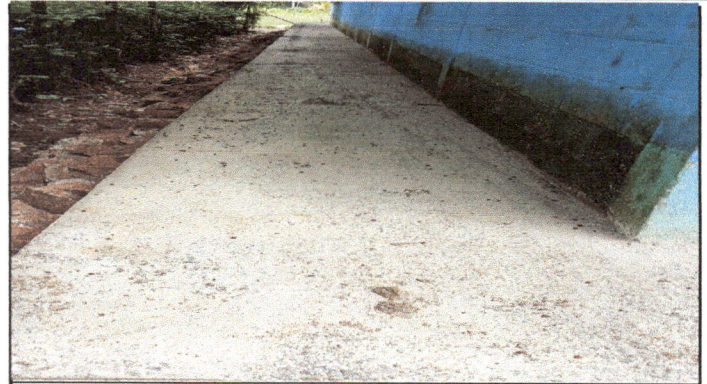
Foto 2: Modulo 2: fotografia de trabajos de mejoramiento de la base perimetral del centro educativo la cual se habia encontrado en mal estado.
